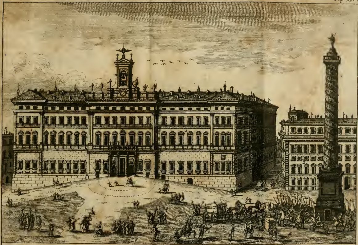
Palais CURIA INNOCENTIANA sur le Mont Citorio. 1. Palais de la Cour de Rome. 2. Palais de la Famille Chigi. 3. Colonne Antonine. 4. La Place Colonne. 5. Logement des Peres de la Mission.
